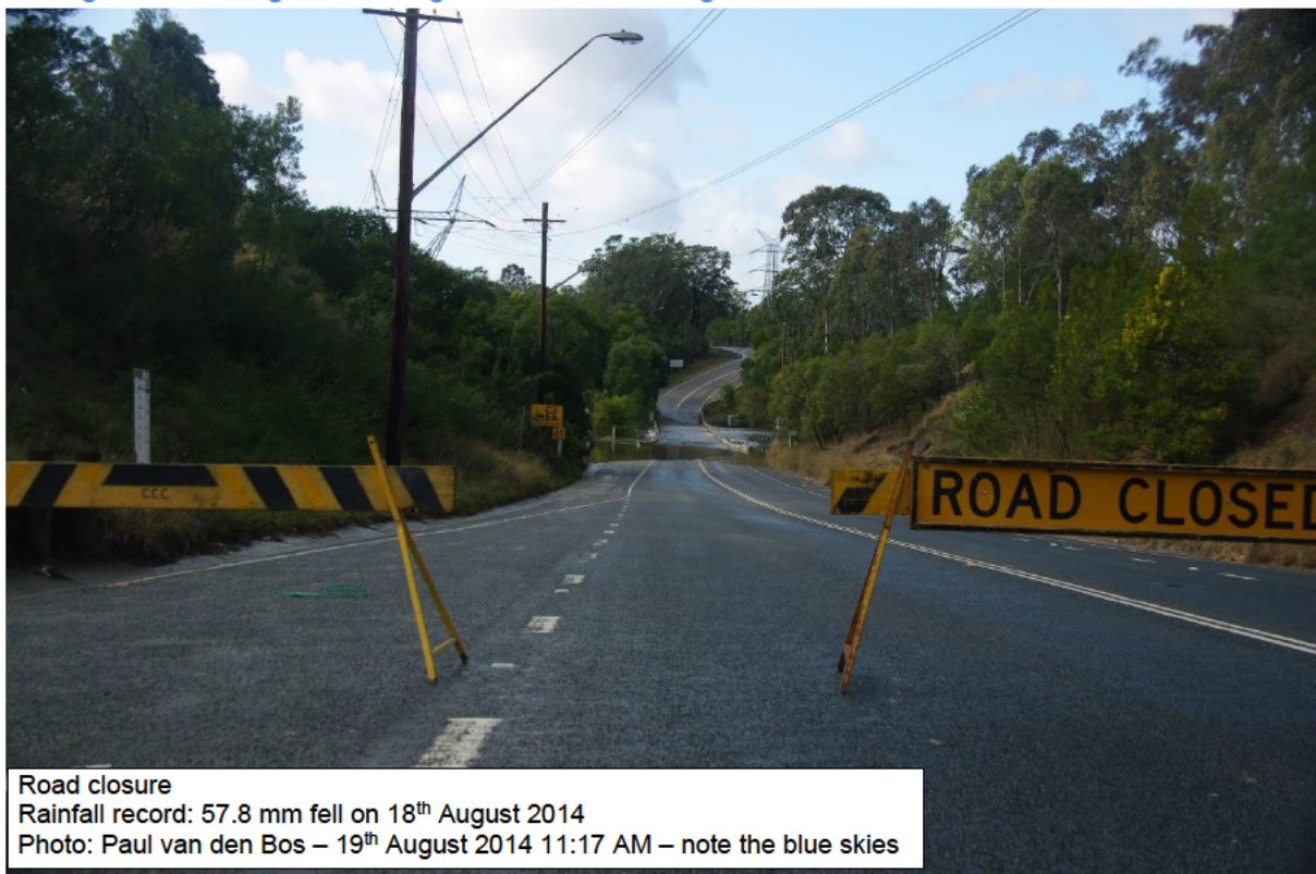
Figure A4 1 Bridge over Georges River on Cambridge Av
